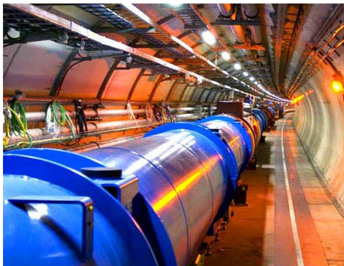
Рис. 6. Так выглядит тоннель коллайдера внутри.
